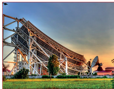
Многолучевая антенна с веерной диаграммой направленности
